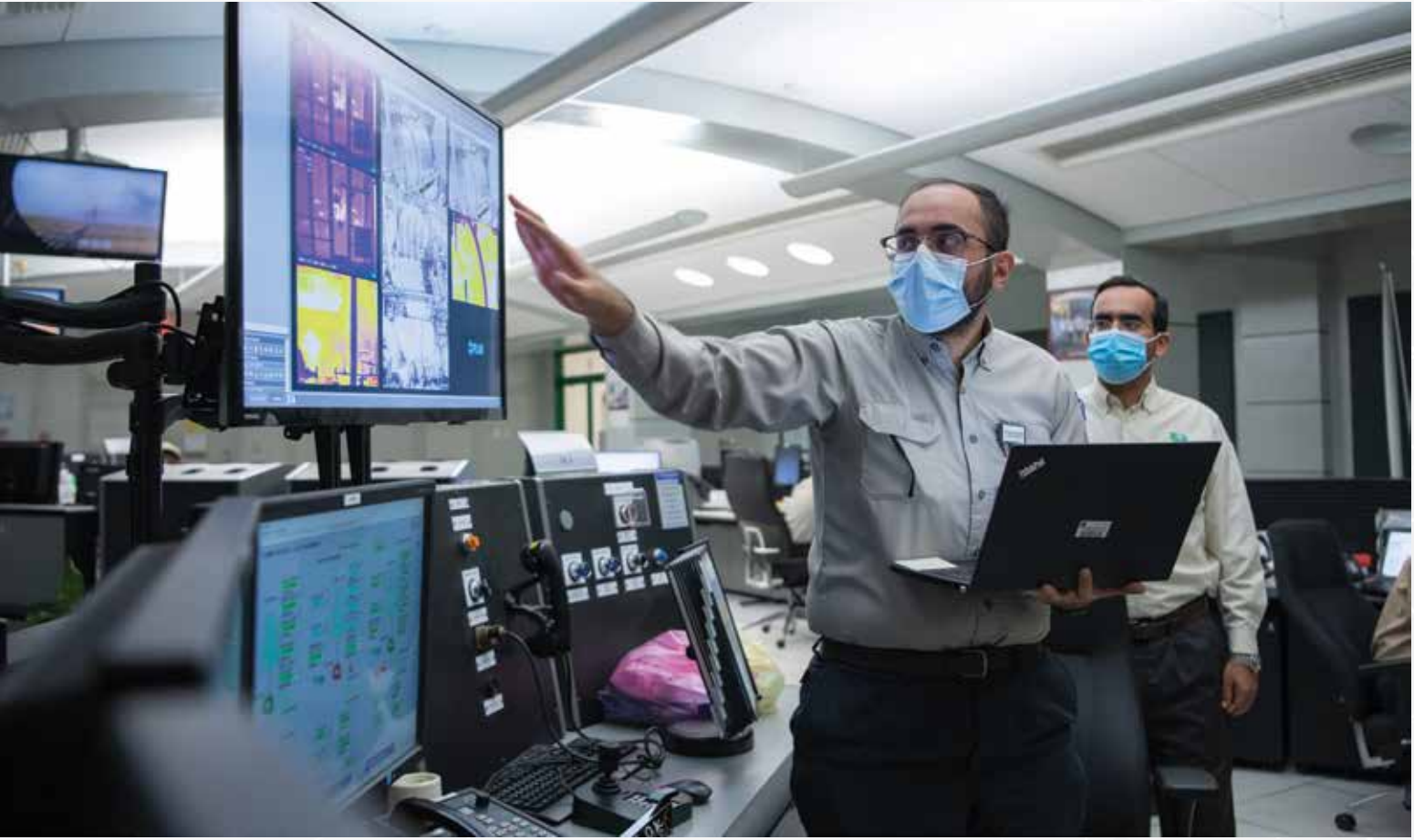
اللجوء لاستخدام وتوظيف التقنية تنجم عنه بيئة عمل أكثر كفاءة وأمانًا وبمعدلات كربون أقل. ويظهر في الصورة، مهندس العمليات تركي الشهيل ومشرف العمليات بداح الهاجري أثناء قيامهما بفحص الصور الحرارية التي تقوم بمراقبة درجة حرارة السطح المعدني التي تبلغ 1200 درجة مئوية لفرن التفاعل في معمل شدقم لاستخلاص الكبريت وتحديد أي عيوب أو نقاط ساخنة تتطلب عزلًا وإصلاحًا فوريًا.
