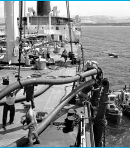
فريق مشترك من موظفي التابلاين وناقلة نفط يرفعون خطوط تحميل النفط الحام المغمورة على السفينة في يوليو 1961م، وهو عمل يتكرر آلاف المرات على مدى عمر فرضة التابلاين في صيدا في لبنان.
